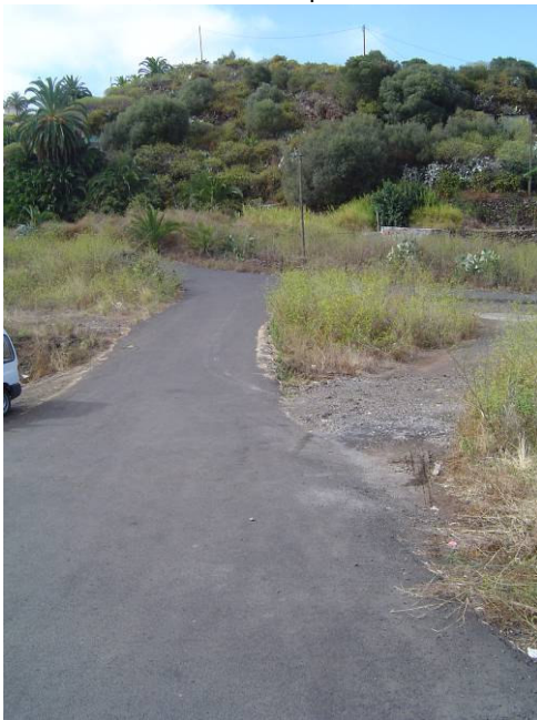
Zona de unión de los Cauces atravesada por una vía
